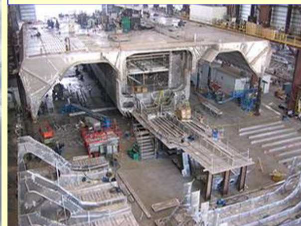
Στάδιο Κατασκευής του LCS Ιούλιος 2006
